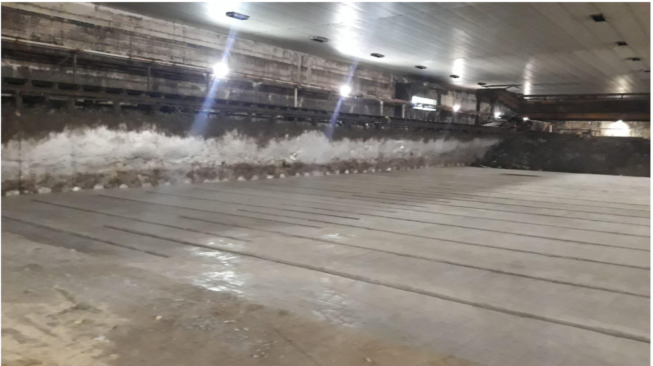
Pavimentazione tecnologica del bacino di bio-ossidazione - fasi di lavorazione
