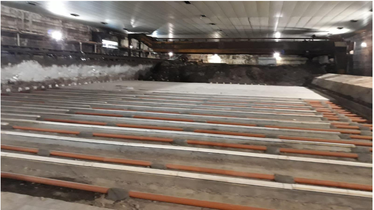
Pavimentazione tecnologica del bacino di bio-ossidazione - fasi di lavorazione
