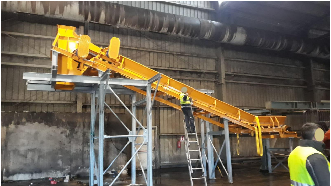
Nastro trasportatore - fasi di montaggio
